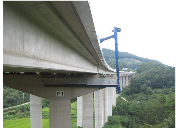
굴절점검차를 이용한 근접조사
