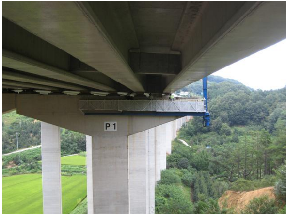
굴절점검차를 이용한 근접조사
