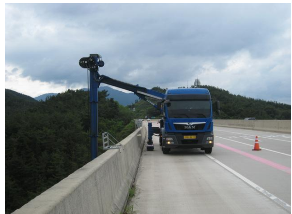
굴절점검차를 이용한 근접조사
