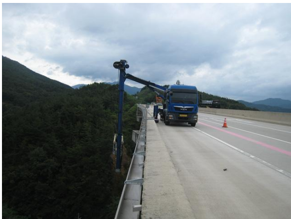
굴절점검차를 이용한 근접조사
